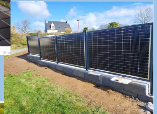
Installés à la verticale, les panneaux photovoltaïques captent mieux le soleil rasant de l'hiver. Image : LTE
